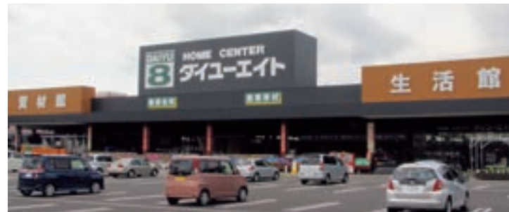
ホームセンター土浦おおつ野店 外観
